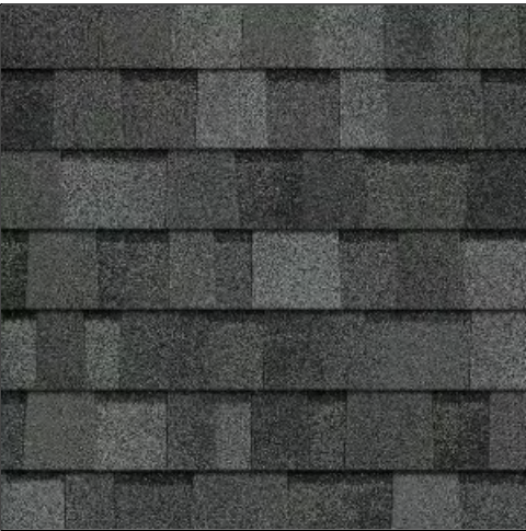
13. Asphalt Shingle Roof Color : Grey
